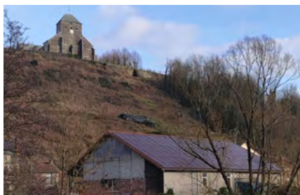
Panneaux bruns sur hangar, pan complet Dun-sur-Meuse (55)
